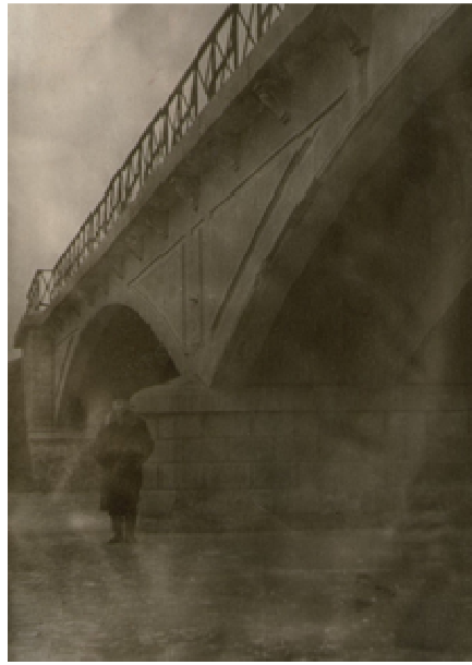
Металеві ковані перила мосту. 1959 р.
