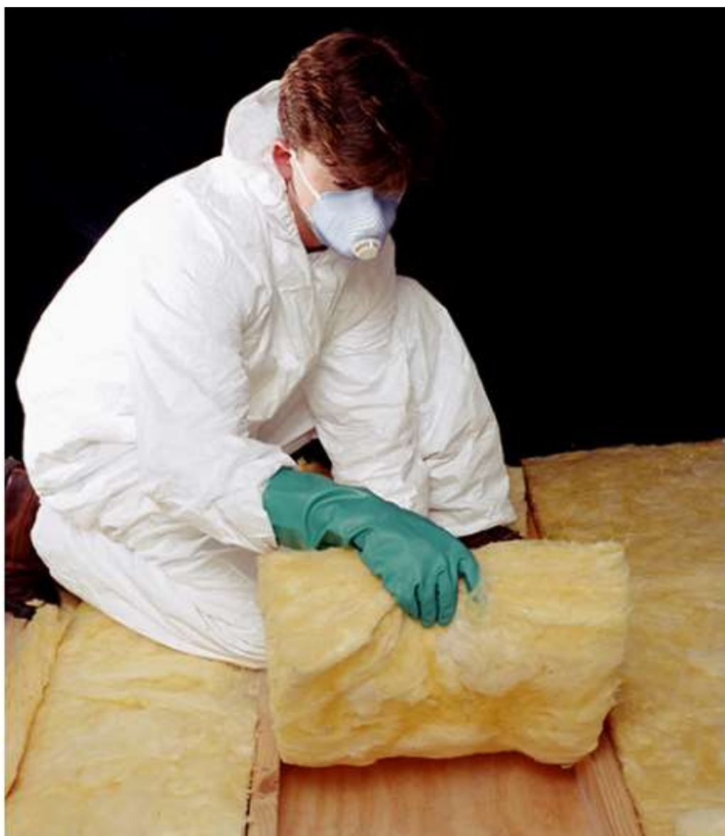
Рис. 1.23. Скловолоконна плита використовується для утеплення стін і стелі для запобігання теплообміну між внутрішньою частиною будівлі та зовнішнім середовищем
