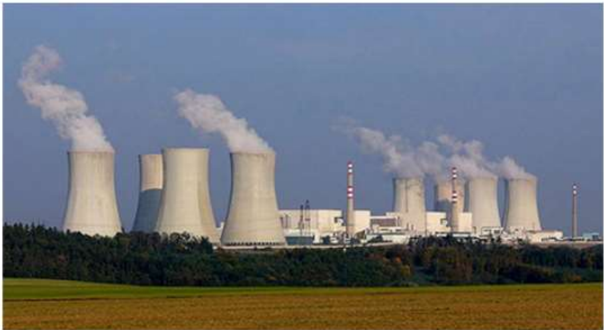
Рис. 4.5. Тепло, що виділяється з атомної електростанції, надходить до градирень, де викидається в атмосферу
