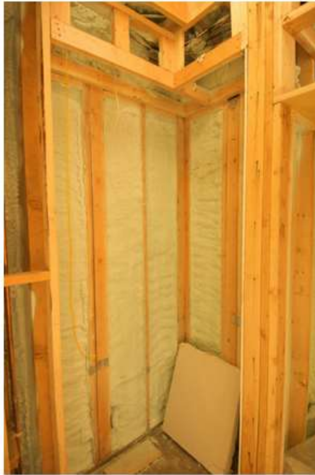
Рис. 1.20 Ізоляція використовується для обмеження теплопровідності зсередини назовні (взимку) і зовні всередину (влітку)
