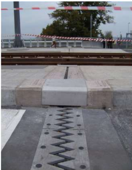
Рис. 1.5 (а) Термічні компенсатори, подібні до цих, дозволяють мостам змінювати довжину без викривлення
