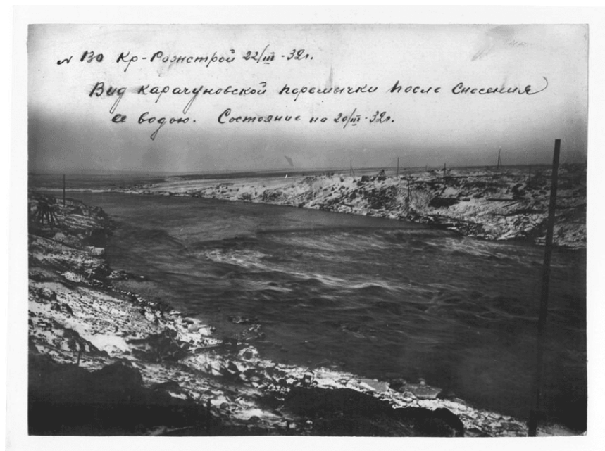
Рис 5. Будівництво Карачунівського водосховища. Перегляд Карачунівської перемички після знесення її водою, 1932 рік.
