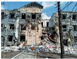
Зруйнована будівля районної адміністрації
