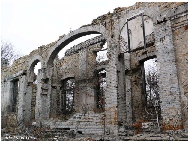
Здание дореволюционного железнодорожного депо в районе Старого Ингульца. ШК + блоки известняка.
