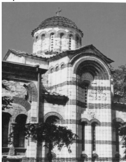
Рис. 5. Церковь Иоанна Предтечи
