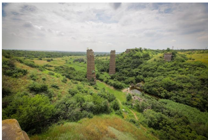
Рис. А.19. Балка «Північна Червона» [34]
