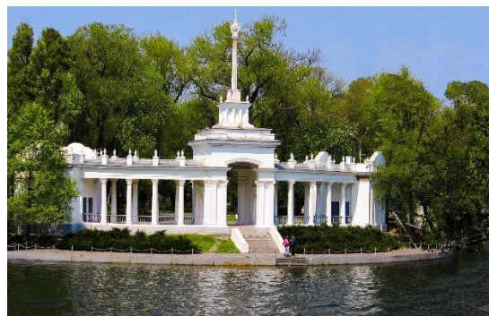
Рис. А.16. Човнова станція [34]
