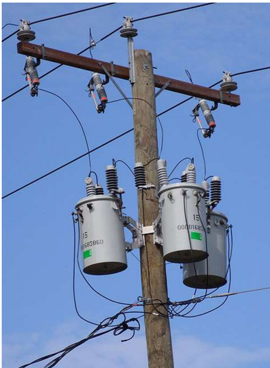
Рис. 5.21. Трансформатори використовуються для зниження високої напруги в лініях електропередач до 110-220 В, що використовуються в будинках
