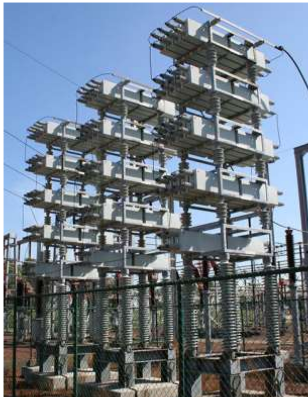
Рис. 5.14. Силові конденсатори служать для врівноваження опору ефективної індуктивності в лініях електропередачі
