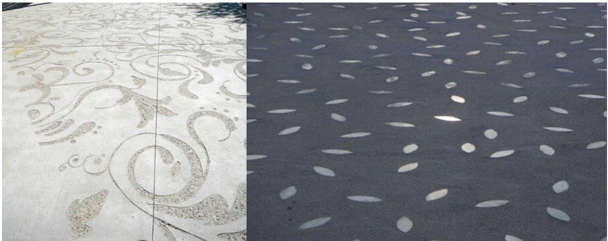
Рис. В. 3.5 Приклади перфорацій на бетоні чи асфальті.
