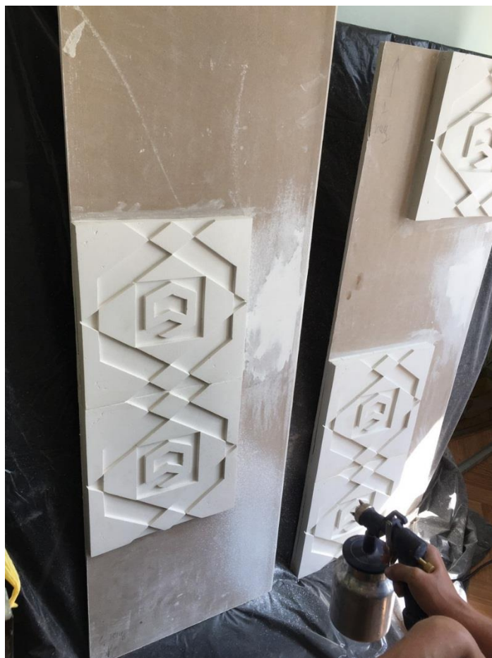
Рис.14 (Покриття плитки водоімульсінкою)
