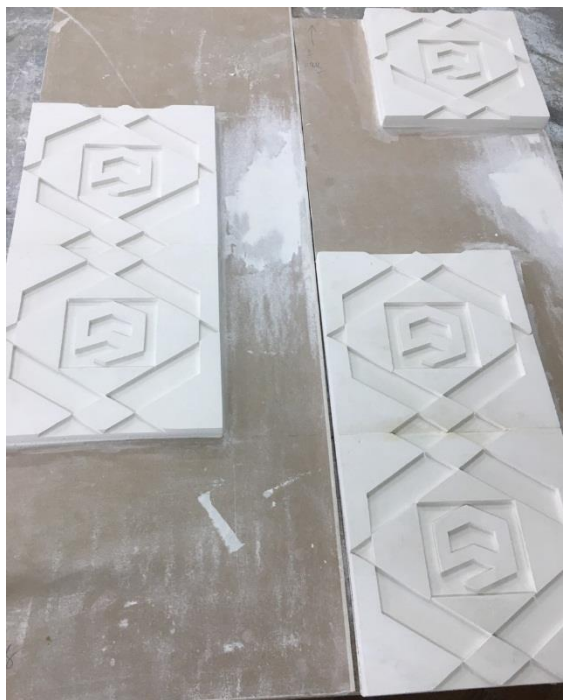
Рис.13(Монтаж плитки на гіпсокартон)
