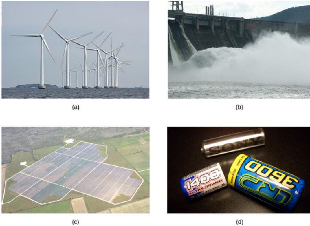
Рис. 6.2. Різноманітність джерел напруги. (а) Вітряна електростанція; (b) гребля; (c) сонячна електростанція; (d) група нікель-метал-гідридних батарей. Вихідна напруга кожного пристрою залежить від його конструкції та навантаження. Вихідна напруга дорівнює ЕРС лише за відсутності навантаження
