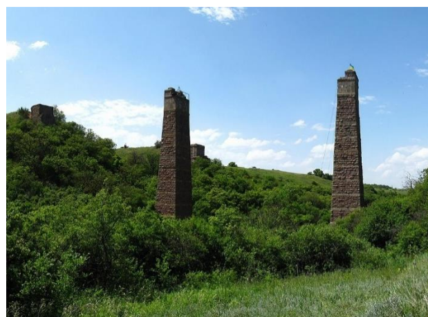
Рис.Е. 2. Балка Північна Червона
