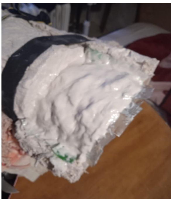
Рис.37.Заповнення опалубок гіпсом
