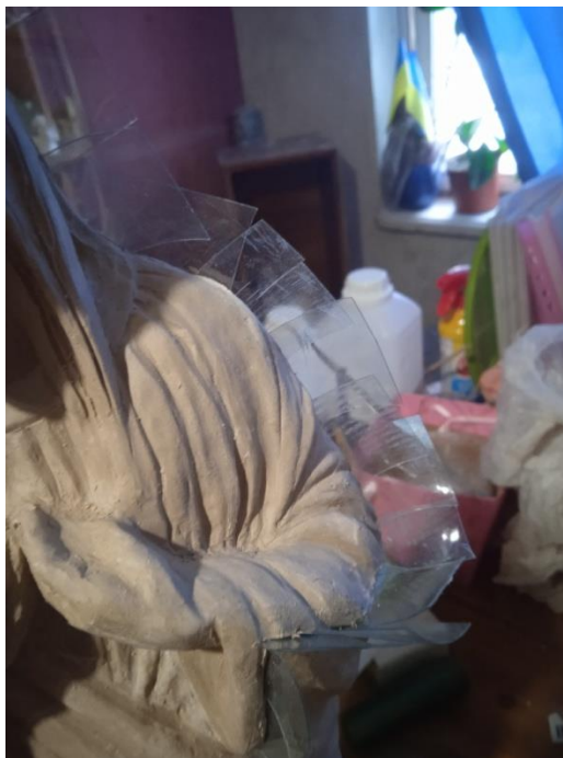
Рис.36 По визначеним смужкам встановлення роздільників та заповнення гіпсом створених опалубок
