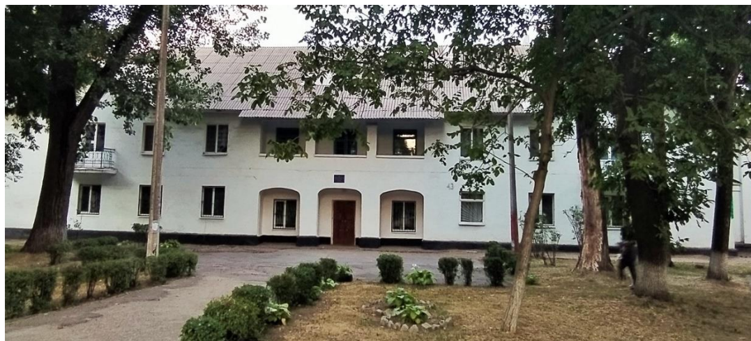
Мал. 3.4. Будинок №43, що побудований силами військовополонених
