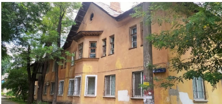
Мал. 3.9. Будинок №17 по вулиці Ватутіна, який побудований силами іноземних інтернованих
