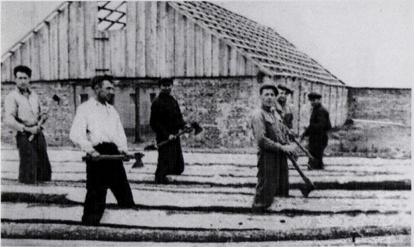
Будівельна бригада на будівництві тваринницьких приміщень колгоспу ім. Б. Хмельницького. Зліва направо: Тананайко Пантелеймон Єврасієвич, Джосюк Григорій, Тананайко Тимофій Давидович, Пуришак Микола Карпович, с. Навіз. Фото 1957 року
