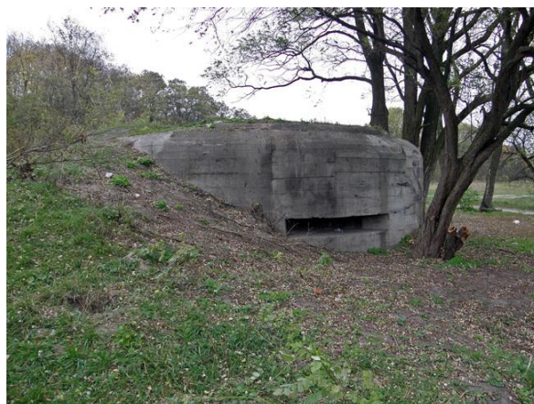
Рис. Д.3. ДОТ №402 у селі Білогородка. В його підземних галереях знімали фільм “Штольня”
