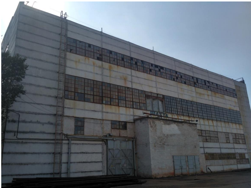
Рис. 3. 2. Будівля не функціонуючої шахти «Артем-2»
