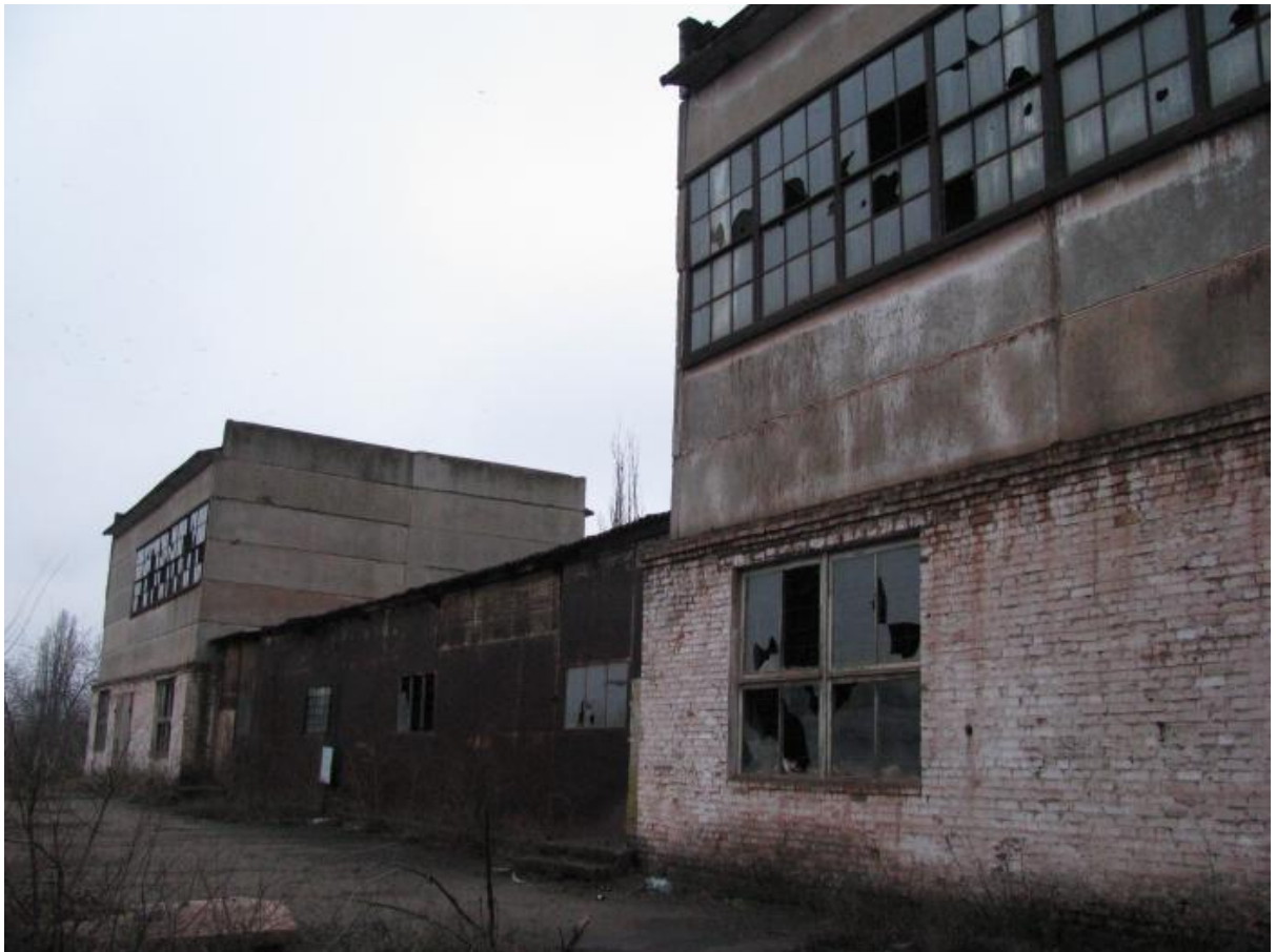
Рис. 3.3. Закинута будівля шахти «Вентиляційна-3»
