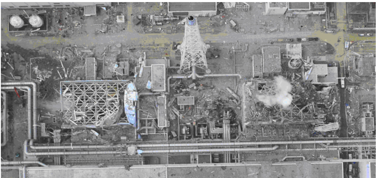
Рис. 2.37. Аерофотознімок руйнувань в результаті землетрусу на АЕС Фокусіма 1
